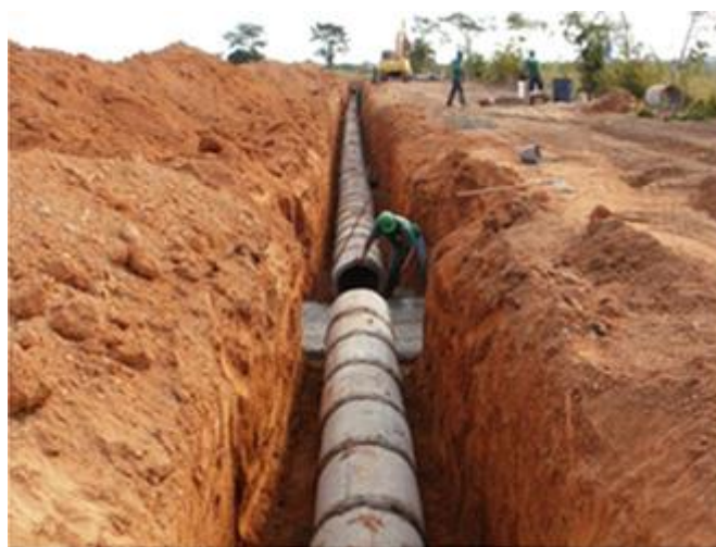
Figura 27: Galeria de drenagem de águas pluvias;
