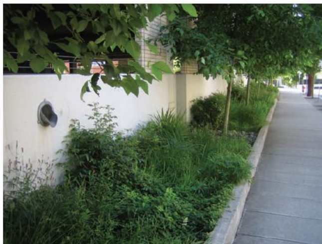
Figura 49: Canteiro pluvial ao lado de uma garagem.
