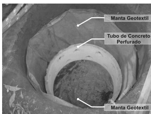
Figura 40: Poço de Infiltração
